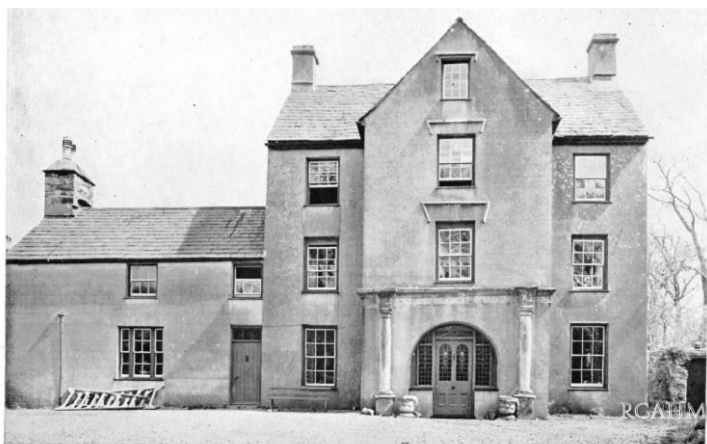
Bodfel Hall, Llannor, Pwllheli
