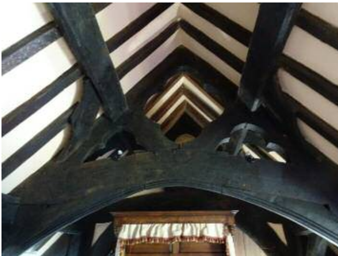
Cyplau'r to/Carved roof-trusses, Llansilin
