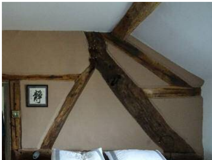
Ffrâm goed a ddaeth i'r golwg yn ddiweddar yng Nghoedpoeth / Timber-framing recently uncovered at Coedpoeth
