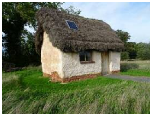
New clay dabbin house Tŷ newydd wedi ei ddabio â chlai (dabbin)
