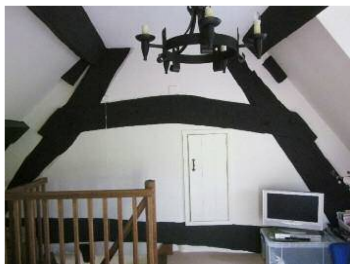
Pâr o nenffyrch, un o bedwar pâr sydd wedi goroesi yn y tŷ hwn o'r 16eg ganrif a fu ar un pryd yn dŷ neuadd yn Sir Ddinbych A pair of crucks, one of four surviving pairs in this 16C former hall house in Denbighshire
