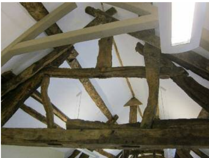
Manylion coed adferedig mewn ysgubor nenfforch yn Llangynhafal, Sir Ddinbych Detail of timbers in cruck barn at Llangynhafal, Denbs
