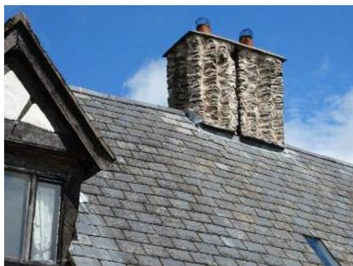
Simnai addurnol/Ornate chimneys, Llansilin
